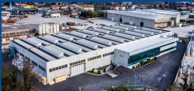
Vista esterna dello stabilimento di MBM a Marenò di Piave (TV)
